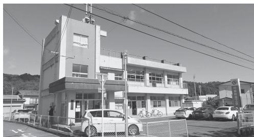
築47年が経過し改修予定の商工会館
