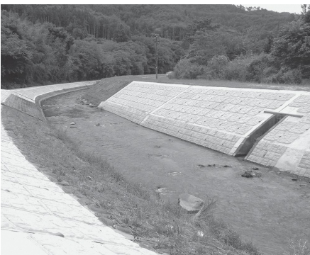
復旧した広瀬川（北成沢地内）
