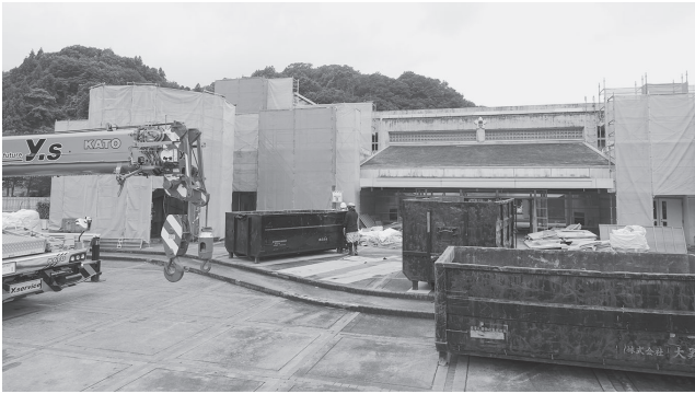
認定こども園に改修中の旧川俣南小学校
