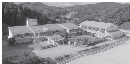
ベニザケの陸上養殖を行う旧富田小学校
