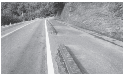
土砂が撤去された349号線
