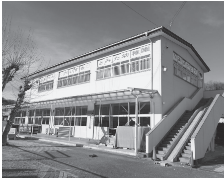
有効な利活用が望まれる富田幼稚園
