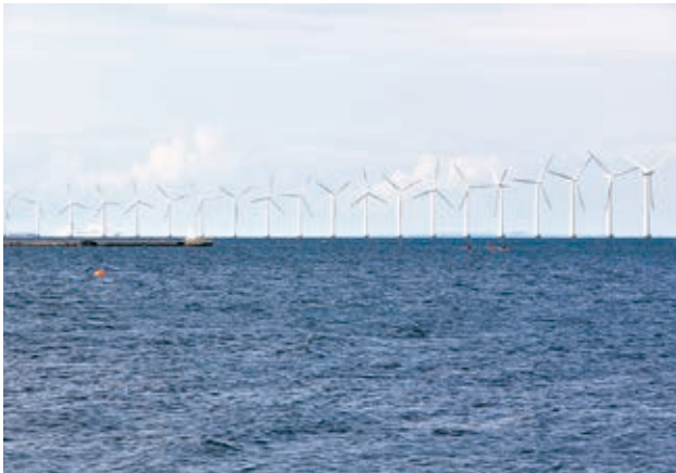
洋上風力発電(デンマーク)
