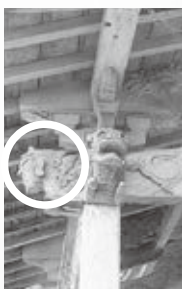
東側の向拝柱の白澤と獅子
