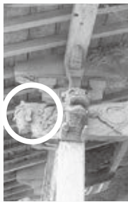
東側の向拝柱の白澤と獅子
