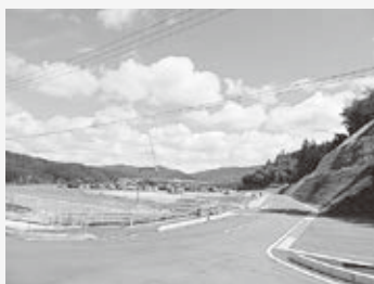
拡張造成工事が完了した中山工業団地
