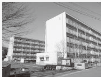
学生寮・移住者向けにリフォームする壁沢住宅
