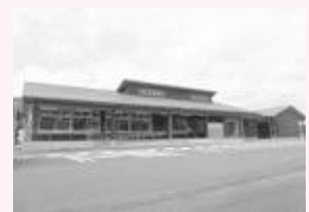
山木屋地区防災まちづく り拠点施設整備事業
