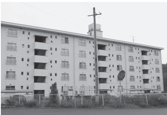
公営住宅長寿命化対策（外壁改修）を行った賤ノ田団地
