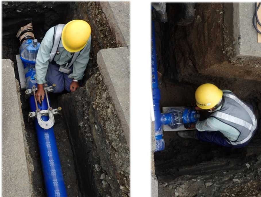
配水管布設工事の様子
