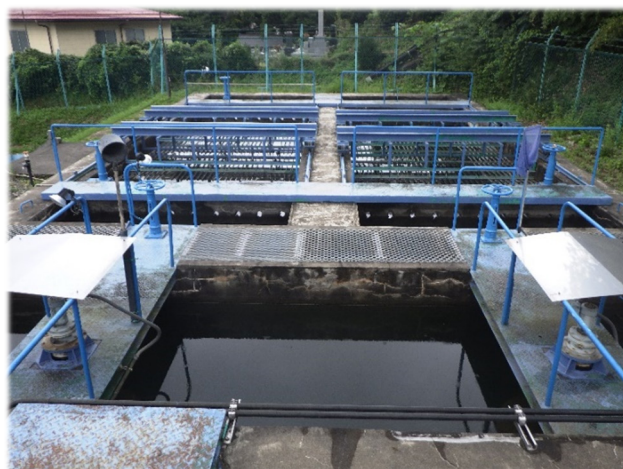
川俣町浄水場 沈殿池
