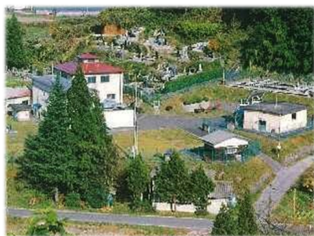
川俣町浄水場
