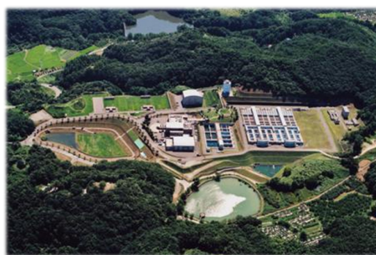
すりかみ浄水場（福島地方水道用水供給企業団）
