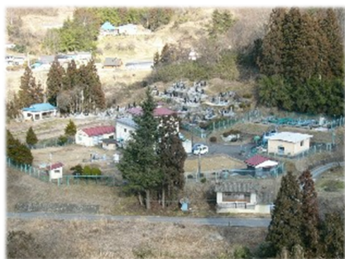
川俣町浄水場
