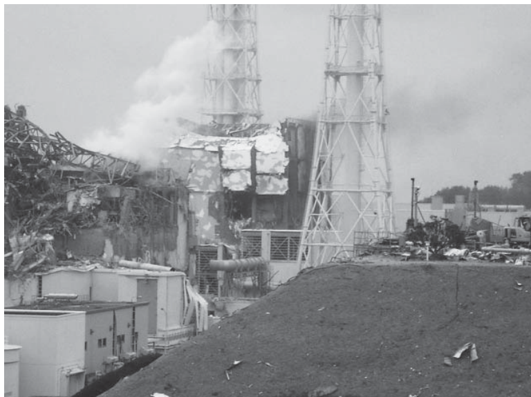
爆発し煙をあげる第一原発3・4号機（写真提供：東京電力㈱ 3月15日撮影）
