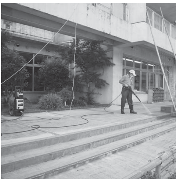
除染作業の様子（飯坂小学校）
