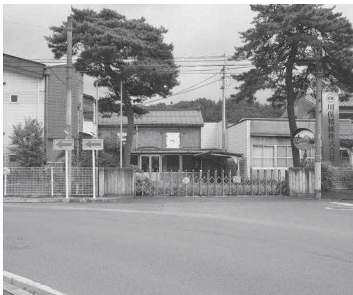
現状放置されたままの川俣精練(株)跡地
