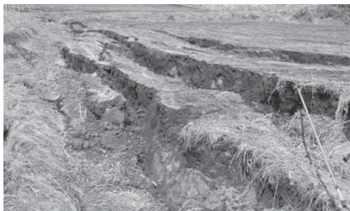
地震で大きく割れた農地（山木屋坂下地内）
