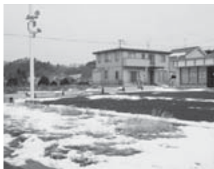
生活排水への対応が問題となっている住宅団地
