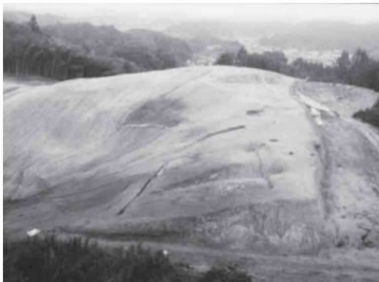
土砂災害が心配される新助館跡地
