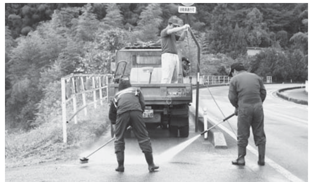
全町除染に先立って実施された線量低減化事業（小島地区）
