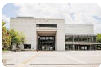
中央公民館耐震補強・ 施設改修工事
