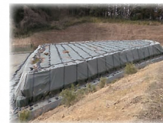
保管状況の様子
