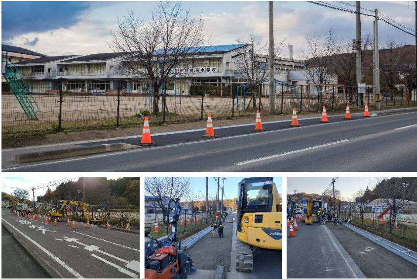
△工事後の乗入部(上)と工事中の様子(下)
