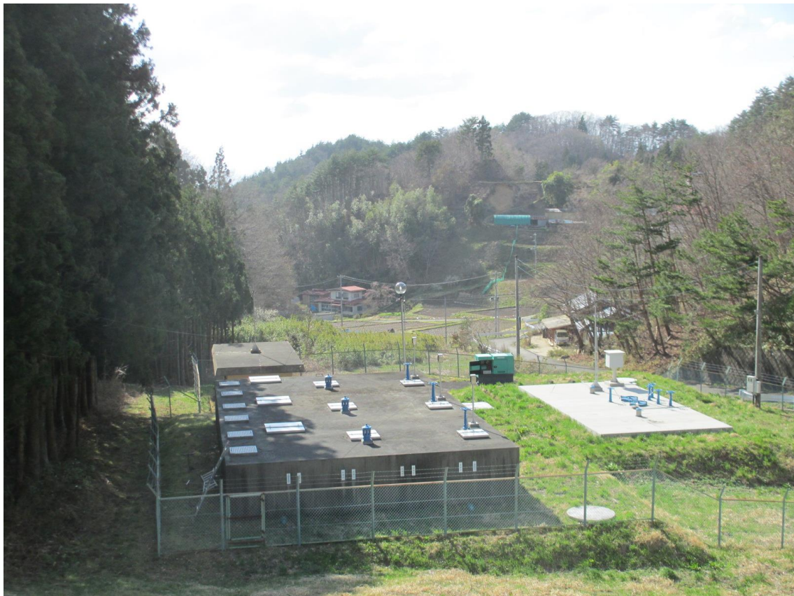
川俣町簡易水道浄水場
