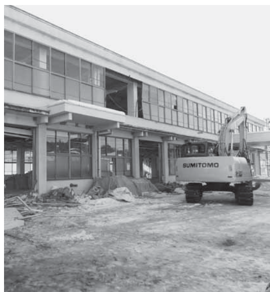
役場庁舎の解体工事が始まりました
