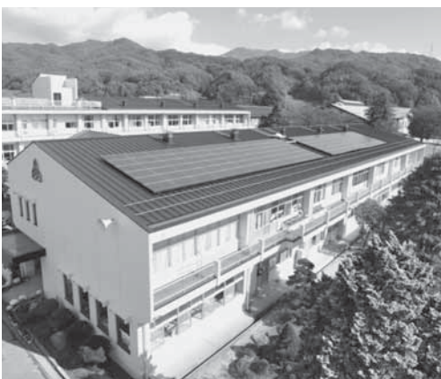
公共施設に設置された太陽光発電設備 (長野県駒ヶ根市)
