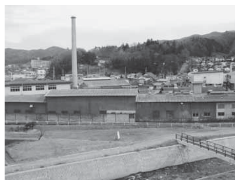
解体を待つ旧川俣精練(株)
