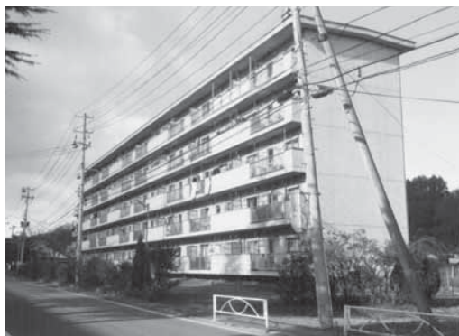
エレベーターが設置されていない町営中層住宅
