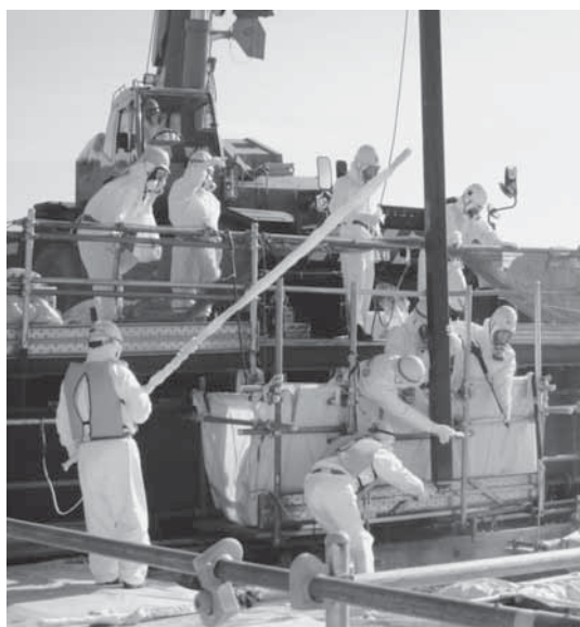
4号機使用済み燃料プールでの作業
