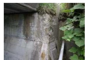
損傷状況（橋台欠損）
