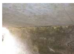
損傷状況（橋台遊離石灰）
