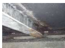
左：主桁腐食状況
