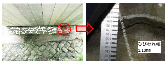
損傷状況（A2橋台ひびわれ）
