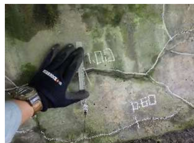
065. 岩倉橋：プレテン床版 (橋長：11.40m、1970年竣工) 橋台前面の二方向ひびわれ ※前回より明らかに進行しており、内部鉄筋の腐食へと進展する可能性が高い。(迂回路無し)
