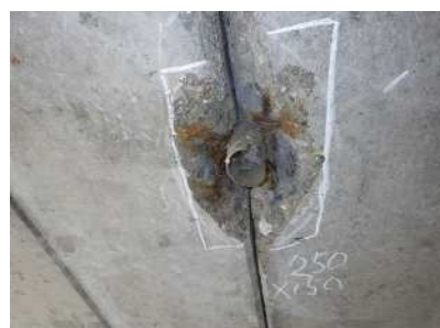
147. 泡吹地橋：プレテン床版 (橋長：11.40m、1965年竣工) 主桁下面のPC鋼材の露出 ※露出鋼材の腐食の進行は、耐荷力の低下に影響する。(迂回路有り)
