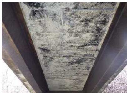
077. 間屋前橋：鋼桁橋 (橋長：13.60m、1970年竣工) 主桁の腐食、床版下面の鉄筋の腐食 ※主桁端部の板厚減少及び床版下面の露出鉄筋の断面減少により耐荷力が低下している。(通行止め規制中)
