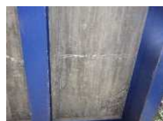
損傷状況（床版ひびわれ、遊離石灰）
