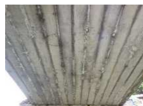
損傷状況 (床版遊離石灰)
