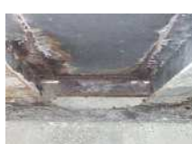
右：横桁腐食状況
