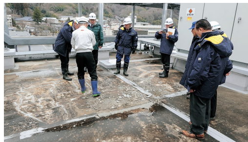
▲ 役場庁舎屋上を調査
