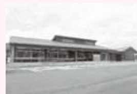
山木屋地区防災まちづく り拠点施設整備事業
