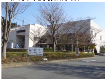
■川俣町中央公民館 (川俣町役場仮庁舎)
