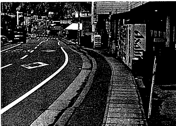
歩道の半分以上が側溝の蓋であり、路面が凸凹していたり蓋の穴があるため、転倒する恐れがあり危険である
