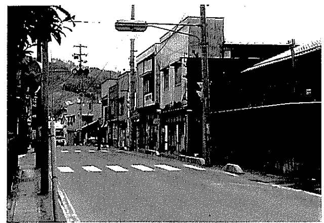
旧国道 114 号線である鶴東・鉄砲町線の歩道は、電柱や支柱等が林立して狭いため歩行者が車道側を歩く光景がみられる
