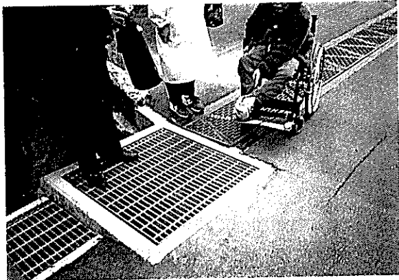
車いすの車輪がグレーチングに挟まってしまう
