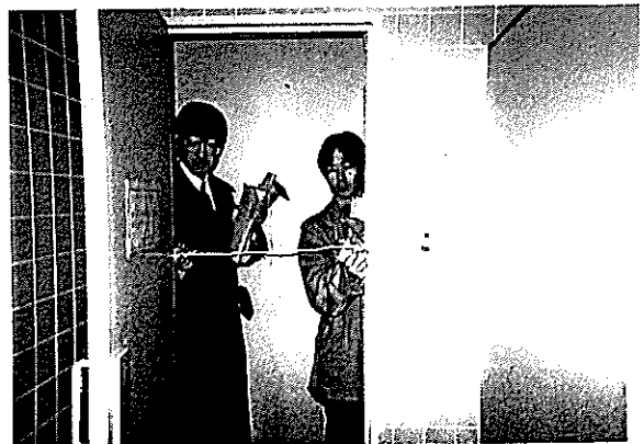
トイレの出入口の幅が65cmでは狭い 80cm以上が望ましいとされている
