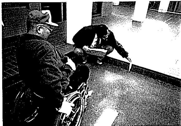
駐車場から建物入口までの段差は16cm、スロープがないため車いすでは上がることが出来ない
