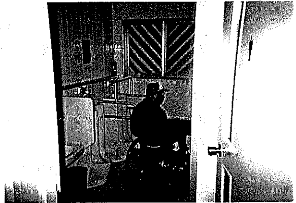
手すり付の小便器も用意されている
