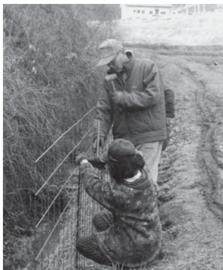
イノシシ対策（小島地区） ワイヤーメッシュ柵設置作業
