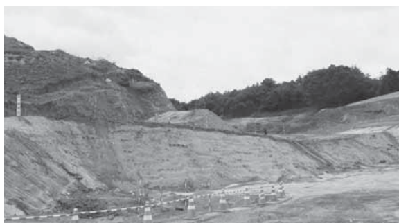
西部工業団地造成工事
