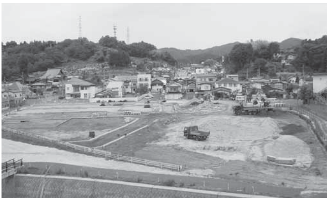
復興公営住宅予定地
