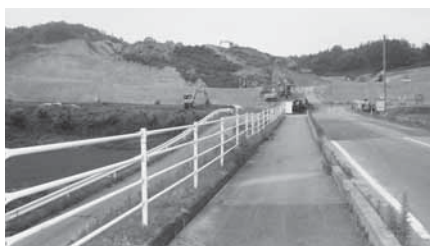
西部工業団地造成工事
