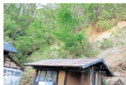
被災した家屋(平成23年5月14日)
