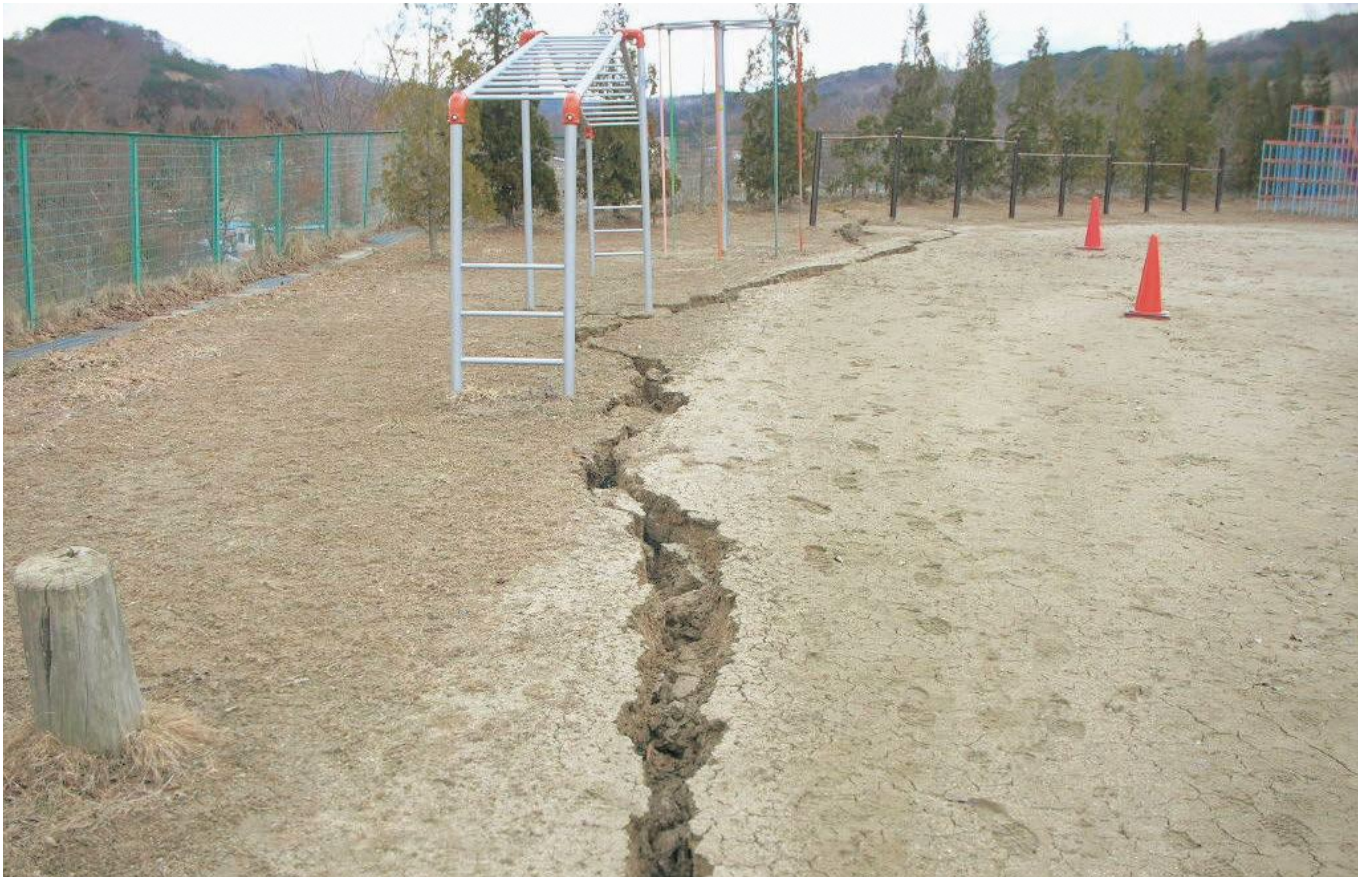
山木屋小学校 校庭の地割れ(平成23年3月24日)
