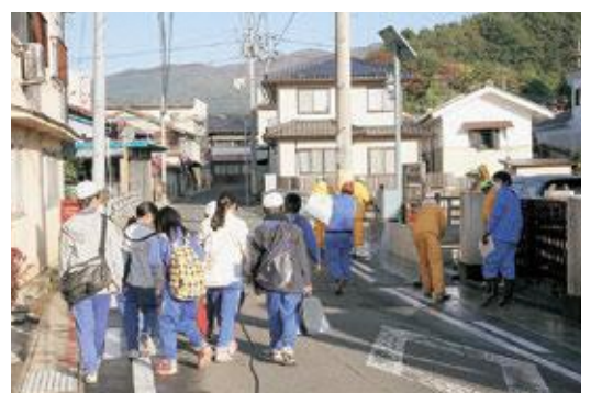
通学路を除染する様子(平成23年10月27日)
