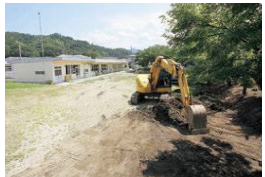
重機で表土を取り除く様子(平成23年7月9日)
