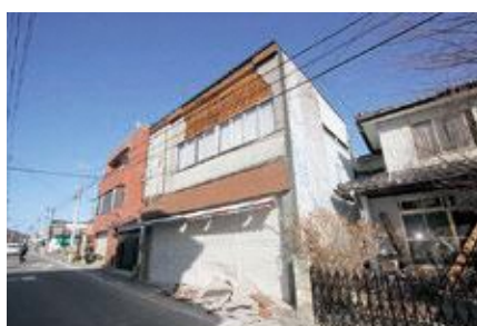
被災した家屋(平成23年3月12日)
