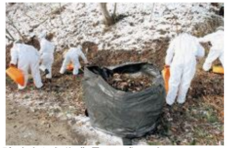
除染を行う作業員(平成23年12月20日)
