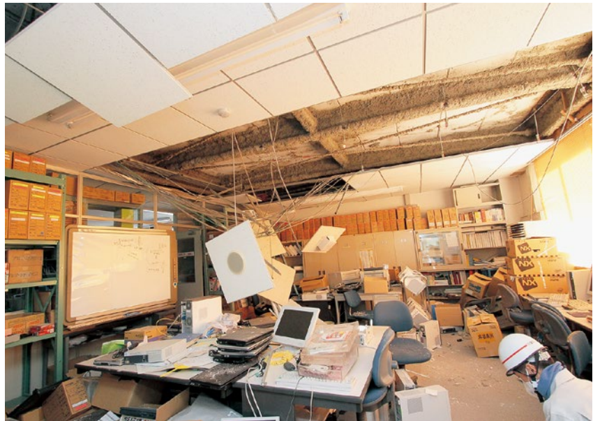
(上) 庁舎の天井材崩落(平成 23 年 3 月 12 日)
