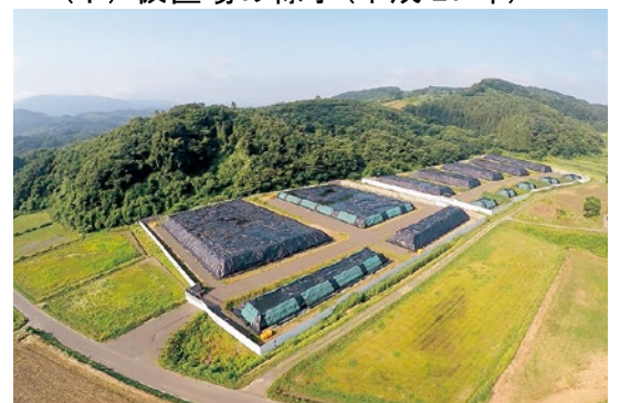
(左) 井戸掘削工事(平成 28 年 7 月 22 日)
